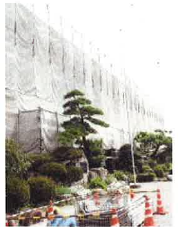
東駐車場の北西角フェンスを一部撤去しました。
